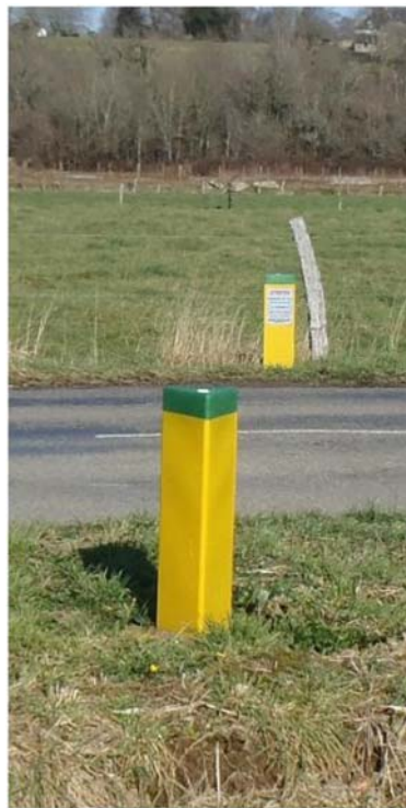
Figure 42 : Bornes utilisées pour une canalisation en arrêt d'exploitation définitif
