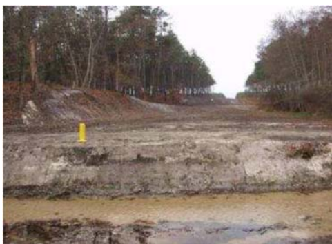
Situation en phase chantier
