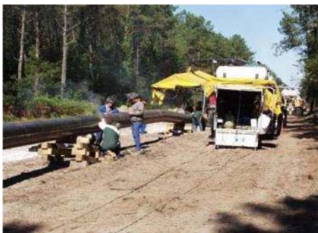
Soudage des tubes
