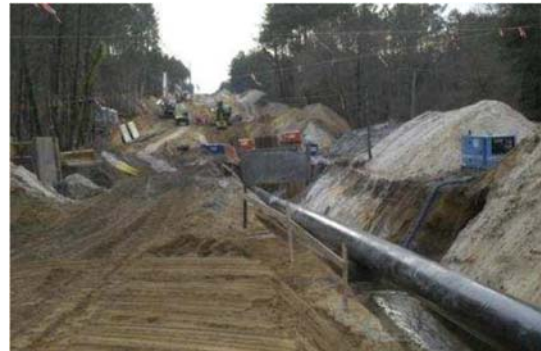
Figure 38 : Mise en fouille
