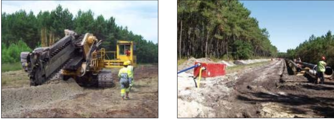
Figure 50 : Travaux de pose de la tranchée drainante et groupes de pompage
