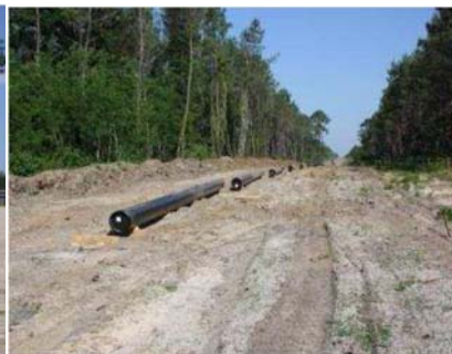
Bardage des tubes sur la piste
