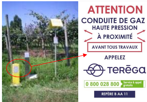
Figure 41 : Bornes de repérage du tracé et plaque signalétique associée
