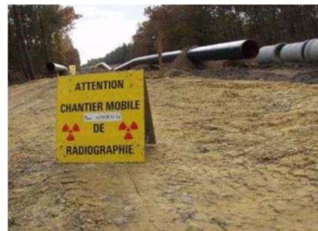
Contrôle des soudures par radiographie
