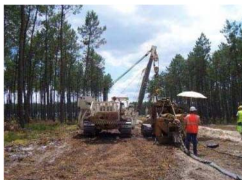
Cintrage des tubes
