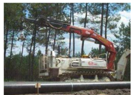
Déchargement des tubes du porte tubes
